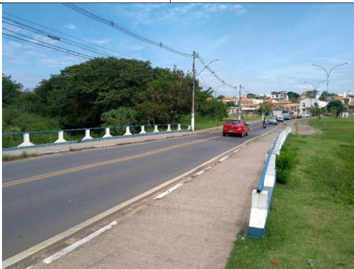
Foto 13: Ponte sobre o córrego, fora do limite do empreendimento.
