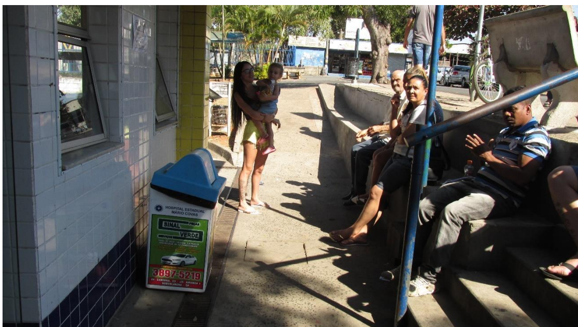
Fotos 9 e 10: Entrada da Recepção do PS: Com nível abaixo da rua, o acesso à Recepção atual se faz por escada ou rampa, com inclinação inadequada à acessibilidade.
