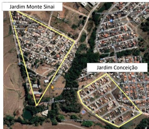
2021 - Ampliação da Ocupação do Bairros Jardim Monte Sinai e Jardim Conceição
