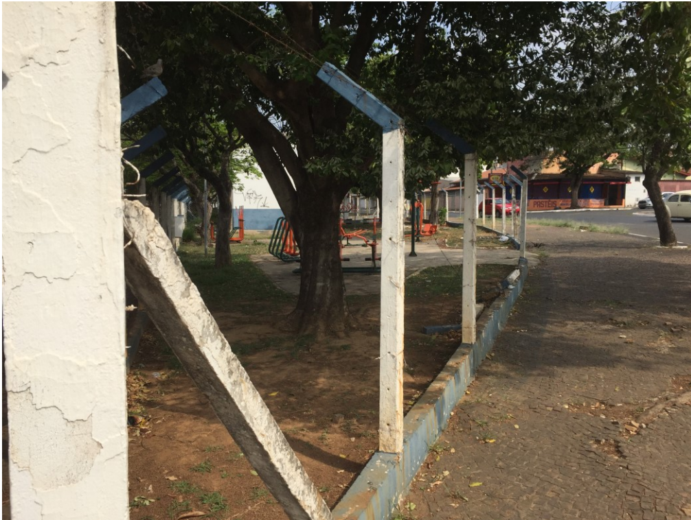
Figura 10 - Vista dos alambrados da praça.
