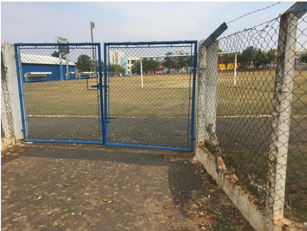
Figura 5 - Vista do Portão da praça.
