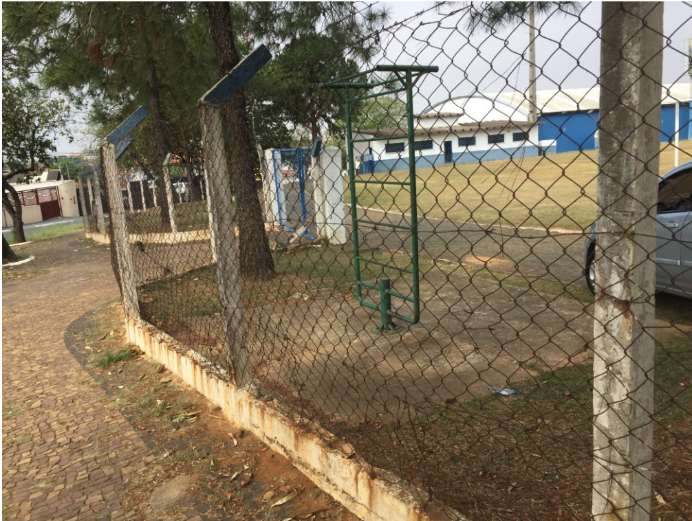
Figura 2- Vista dos alambrados da praça.
