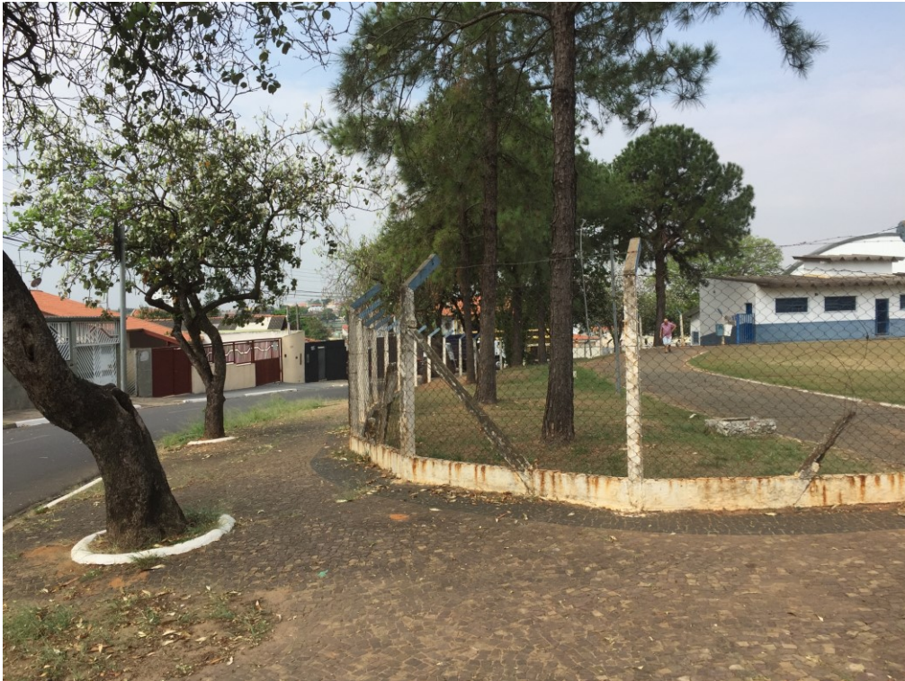
Figura 4 - Vista dos alambrados da praça.
