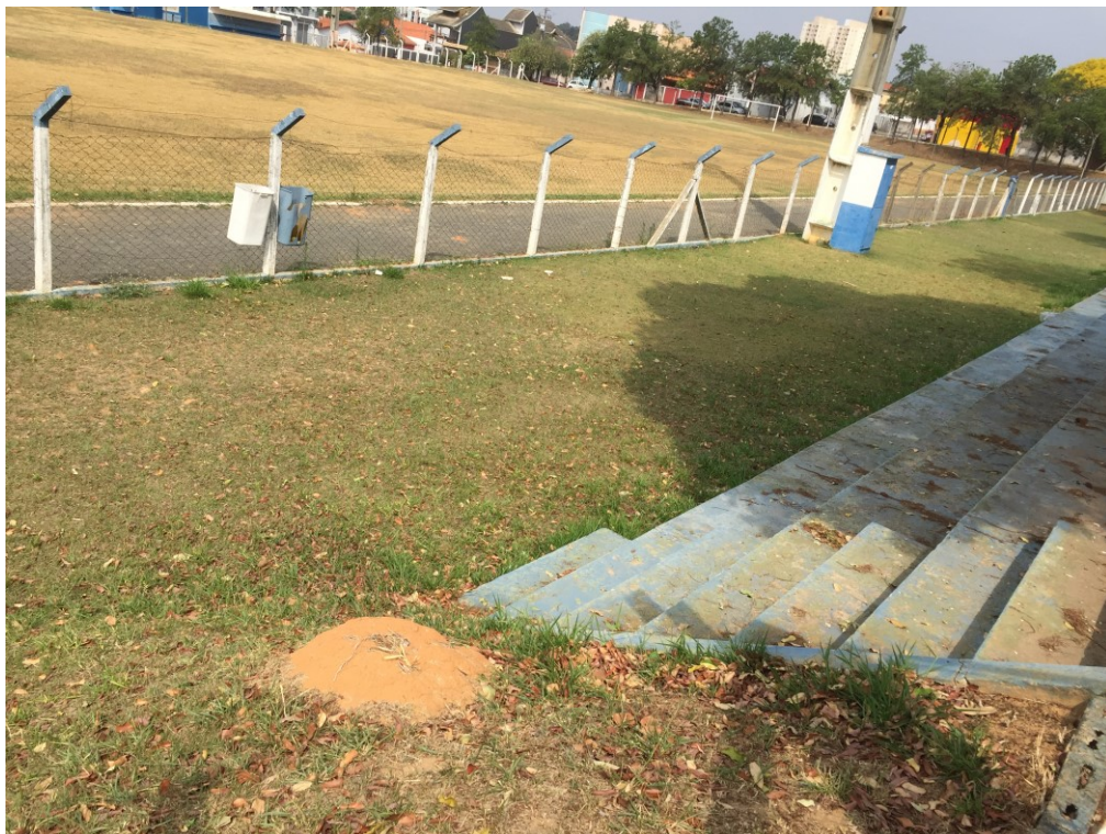
Figura 8 - Vista das arquibancadas.
