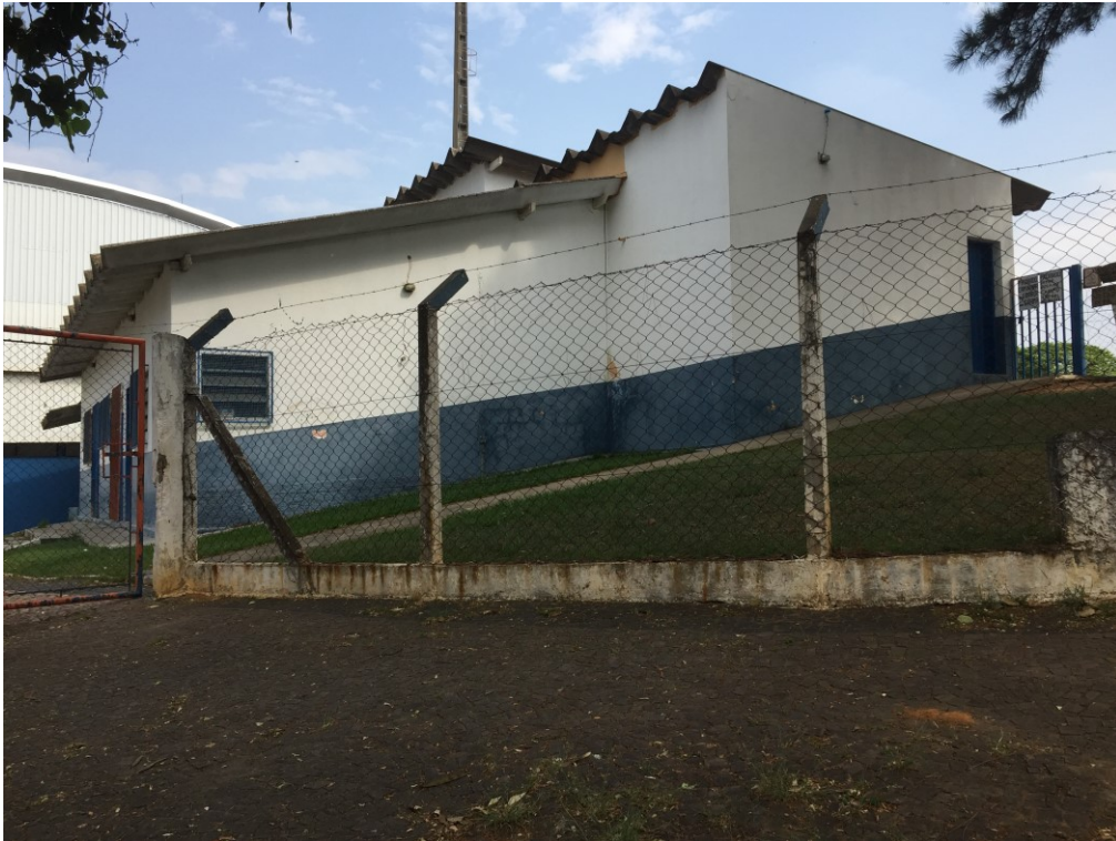
Figura 12 - Vista dos alambrados da praça.
