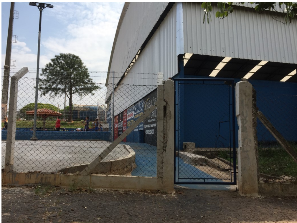
Figura 9 - Vista dos alambrados da praça.
