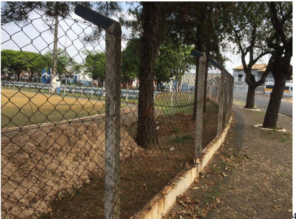
Figura 3 - Vista dos alambrados da praça.
