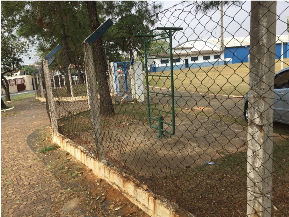
Figura 2- Vista dos alambrados da praça.
