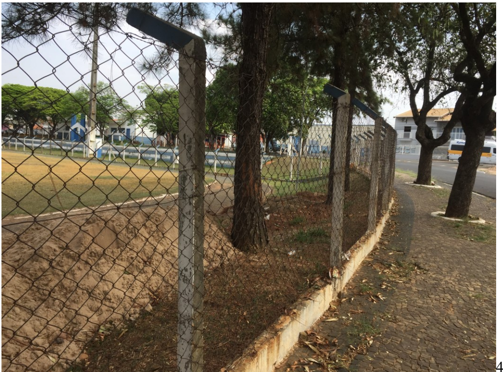
Figura 3 - Vista dos alambrados da praça.
