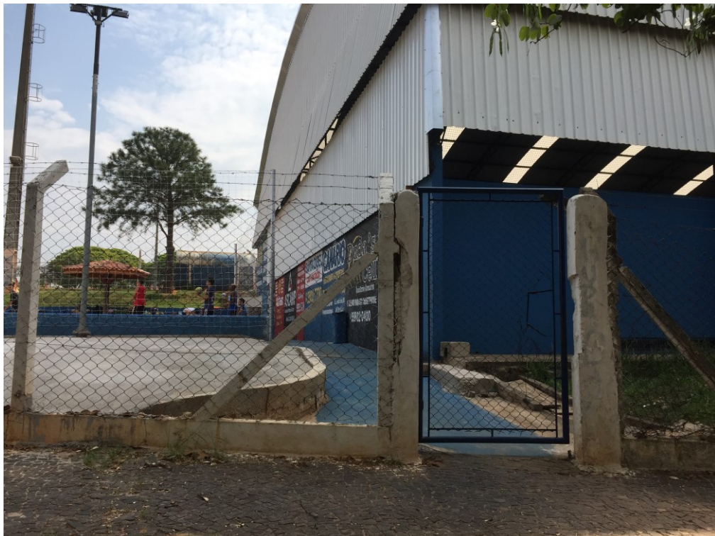
Figura 9 - Vista dos alambrados da praça.
