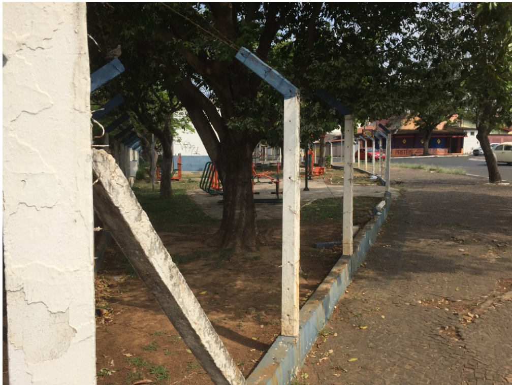
Figura 10 - Vista dos alambrados da praça.
