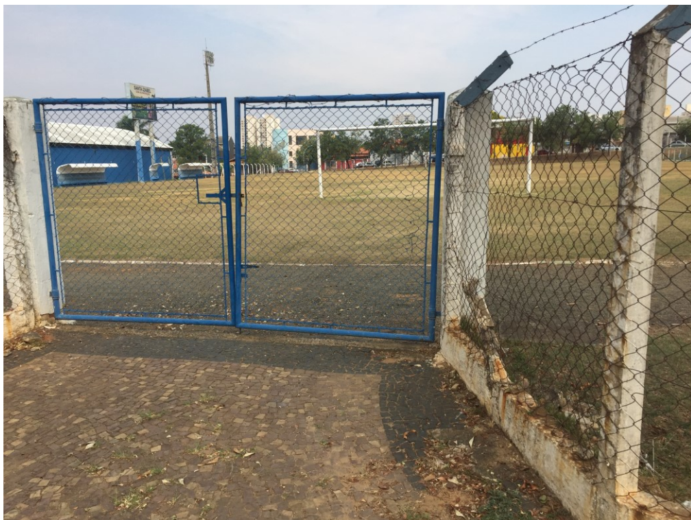
Figura 5 - Vista do Portão da praça.
